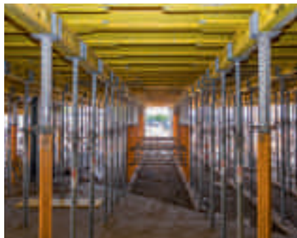
GT 24 -palkkia käytettäessä päästään pienempiin palkki- ja holvitukimääriin. Säästöt kustannuksissa ovat huomattavat.
