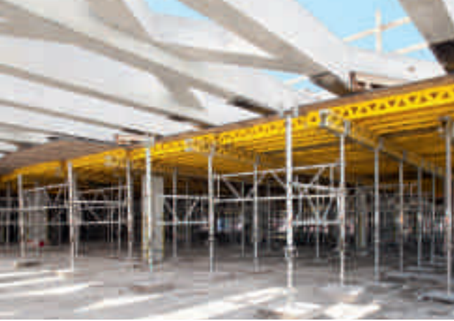
MULTIFLEX toimi holvimuottina paikallavalettaville palkeille PEP-holvituilla PRK-kehysten kanssa.
