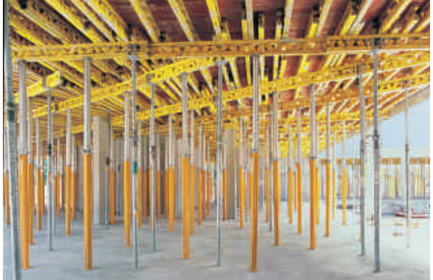
MULTIFLEX GT 24 -palkit niskoina pyöreän säiliön muotituksessa.
