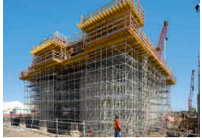
Massiiviset kuormat siirrettiin maahan 10 – 12 m korkeudelta PERI UP Rosett -telineistä ja MULTIFLEX-holvimuotista koostuvasta ratkaisusta.
