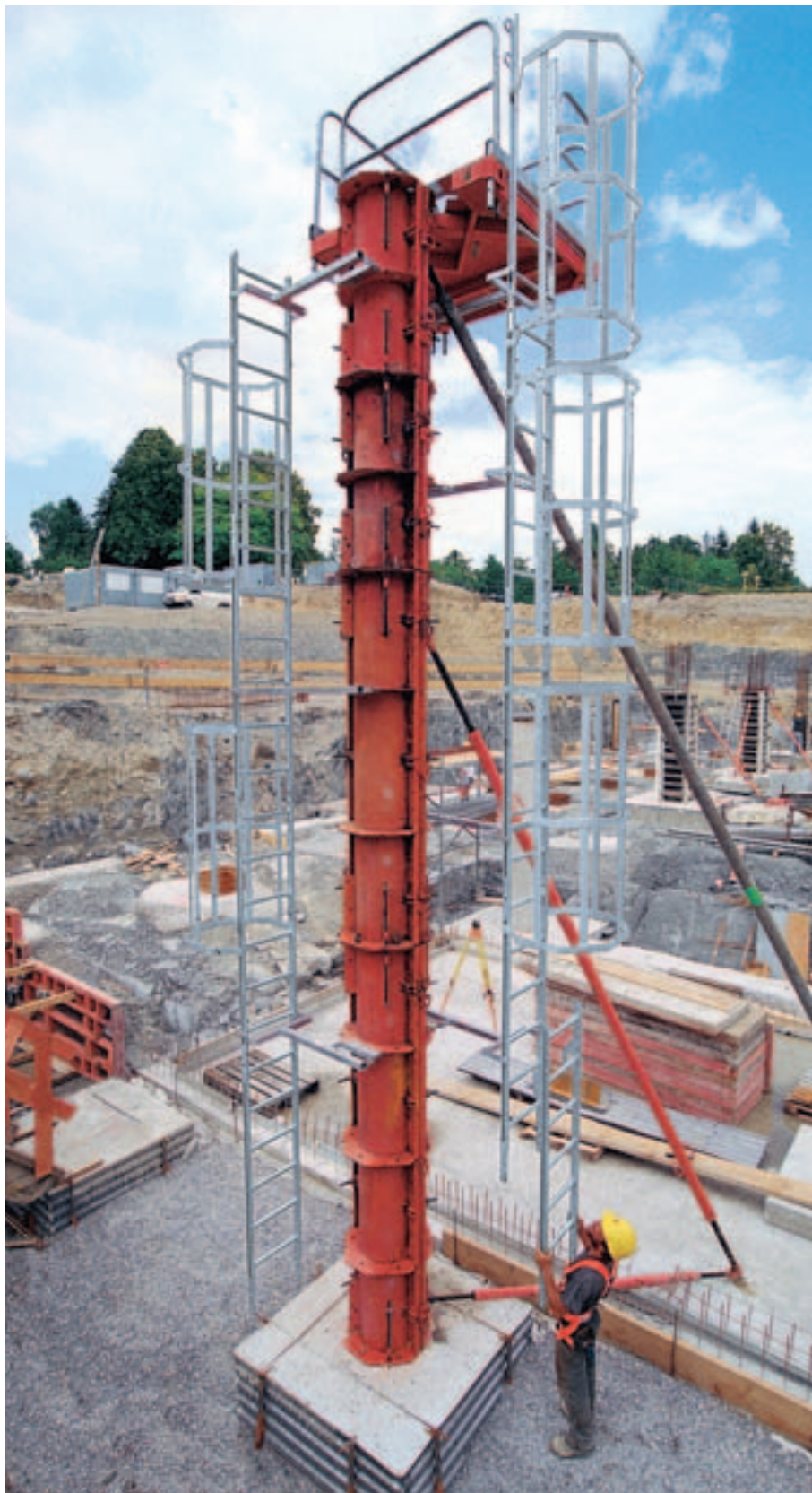
Betonointitasolla on turvallista työskennellä kaikissa korkeuksissa.
