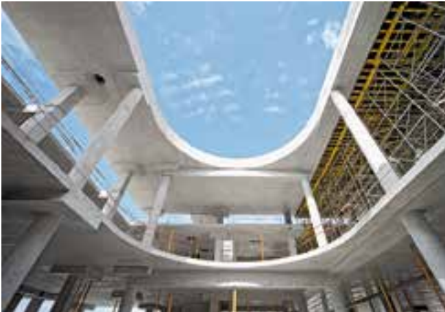
30 cm paksu laatta muotitettiin MULTIFLEX-holvimuotilla.
