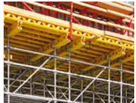
GT 24 -palkkien käyttö tuplaniskoina yhdessä PERI UP Rosett Flex -tuennan kanssa siirtää raskaat kuormat suurissa korkeuksissa.
