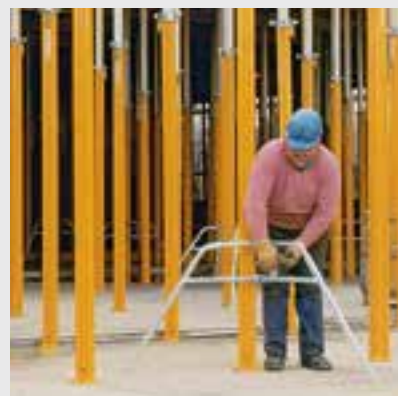
Universal-asennustuki helpottaa asennusta. Vaakuorimat siirretään muotin kautta rakenteeseen.
