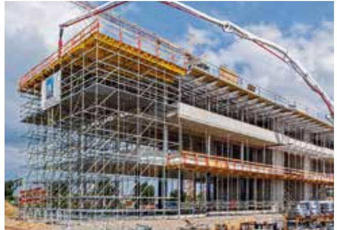
Kaikki yhdestä paikasta: Sekä seinä- ja holvimuotit että rauditustelineet ja tuentaratkaisut olivat optimaaliset projektin tarpeisiin.
