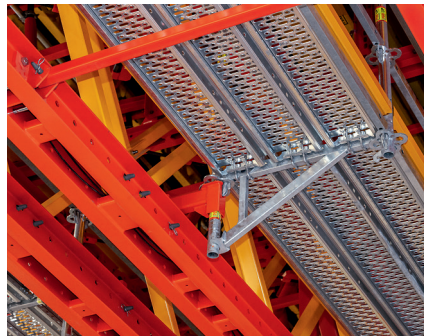
Yhteensopiva PERI UP -järjestelmään PERI UP -telinejärjestelmän osilla varustetut turvalliset kulkutiet voidaan helposti asentaa ristikkopalkkien väliin tai viereen.
