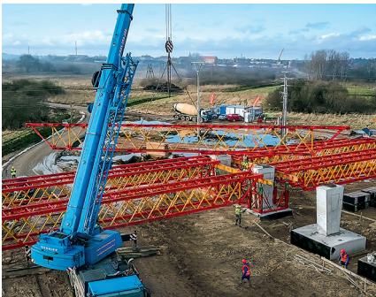
Pienemmät asennus- ja nosturajat VRB HD -ristikkopalkki isoille jänneväleille tarjoaa suuren kantavuuden pienellä omapainolla.
