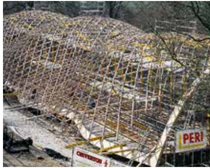
MULTIPROP-tuet kannattelivat kaarevan muotoista puurakennetta.
