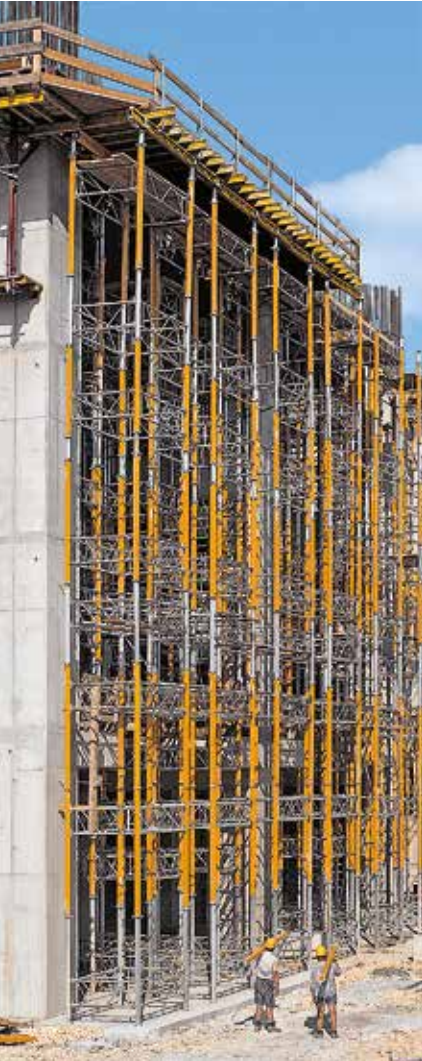
20 metriä korkeat MULTIPROP-tukitornit tukemassa holvin ulokkeellista reunakaistaa.
