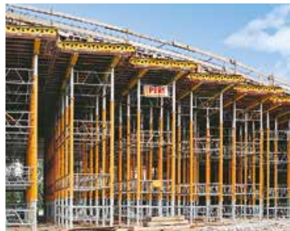
MULTIPROP-tukitornit tukijalkoina pöytämuoteille.
