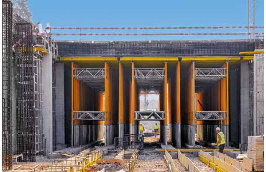
Erityisesti korkeissa holveissa MULTIPROP-tukitornit ovat kustannustehokas vaihtoehto tavallisesti käytetyille tukitelineille.
