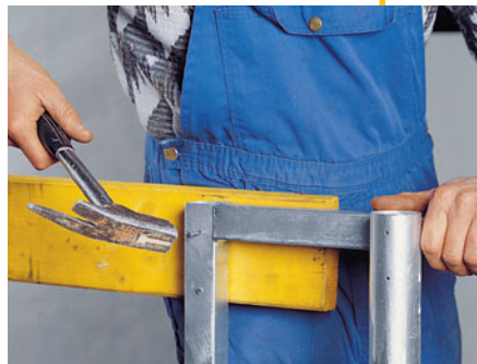
Kaidekehässä olevat reiät mahdollistavat kaidepuiden naulaamisen.
