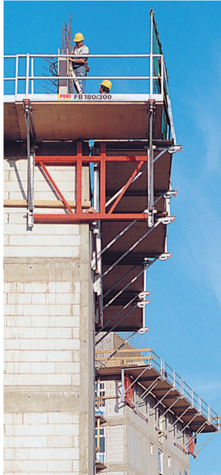
Tasokuva niveltyötasosta FB 180-3 ja uloketasosta FEB (vasenkätisenä)
