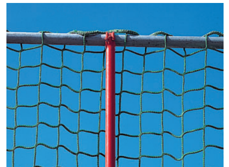
Telineputki on pujotettu turvaverkon silmukoihin ja kiinnitetty sitten kaidetolpan jatkeen liittimeen.
