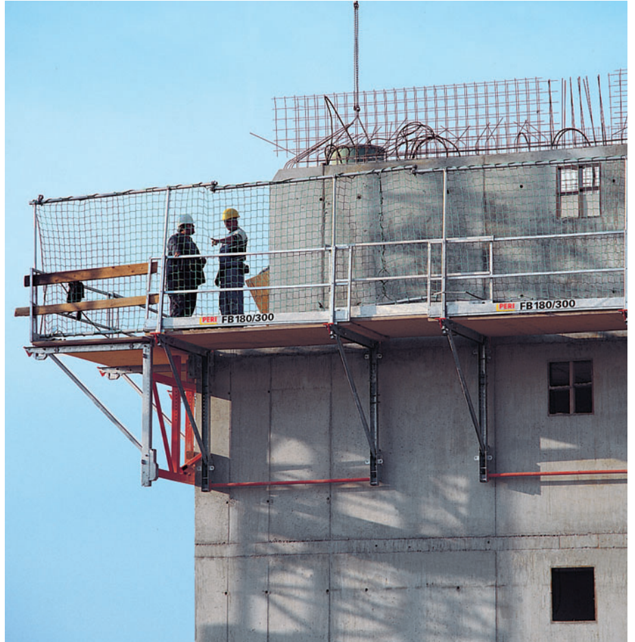
Nivelytason FB 180-3 kanssa käytetty turvaverkkoa.
