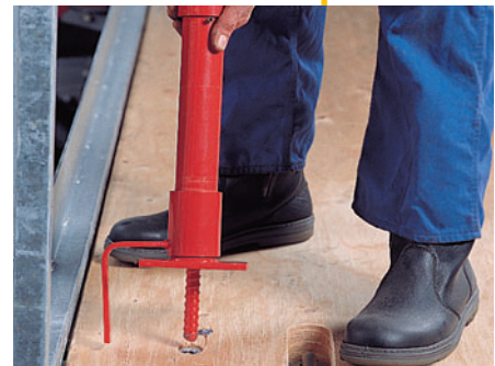
Päätykaidetolppa FBP kierretään niveltyötasossa oleviin kiinnityskohtiin (DW 15) ja lisätään puukaiteet.
