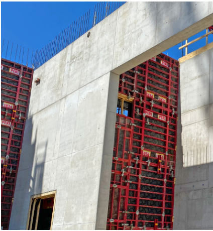
MAXIMO-järjestelmän avulla päästään tässä projektissa vaadittavaan 24 metrin valukorkeuteen.
