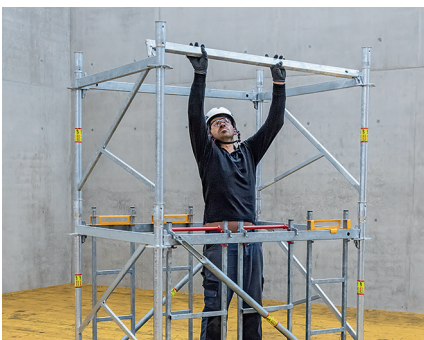
Juoksut voidaan asentaa nopeasti turvallisesta asennosta. Itsekiinnittävät juoksut lisäävät työturvallisuuden tasoa.
