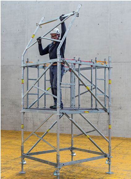
Kun kehys on asetettu alle 45°:een kulmassa tulppaanin muotoiseen putken liitospäähän, käännetään se pystyasentoon.
