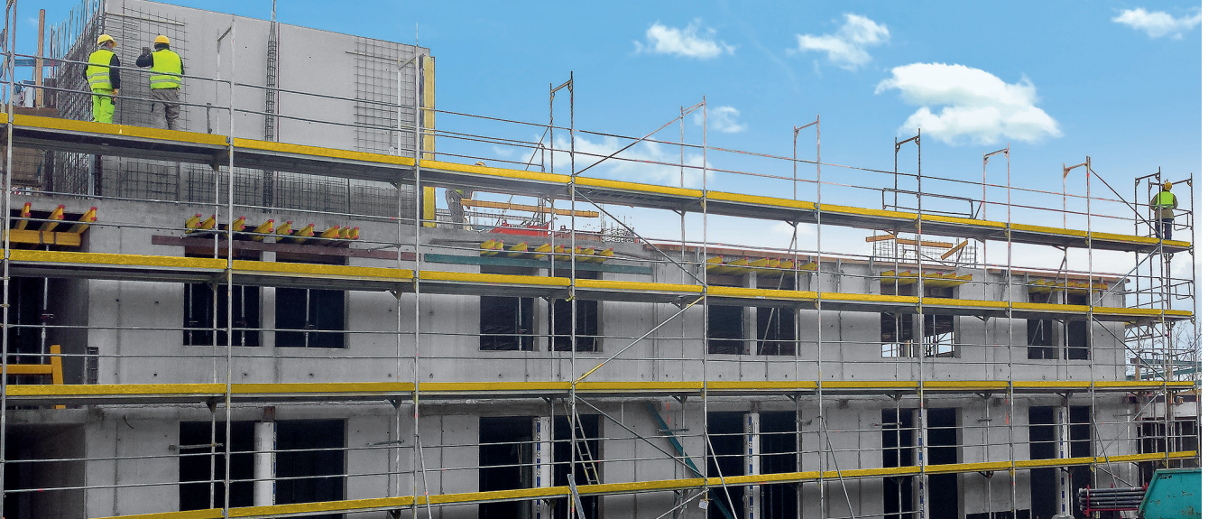
Varausmuotit takaavat mittatarkan tulokset ovi- ja ikkuna-aukkoja tehtäessä
