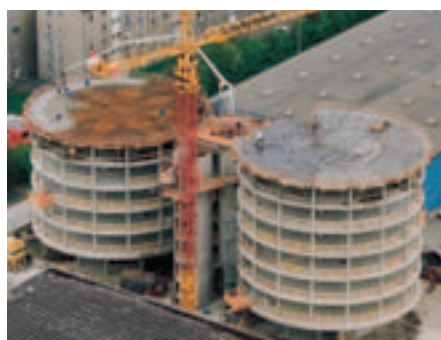
Puolisuunnikkaan muotoisia UNIPORTAL -pöytämuotteja pyöreässä toimistokohteessa.
