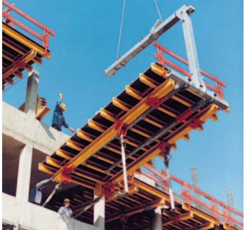
VT-moduulipöytää siirretään nostohaarukalla 1,0 t / 5,0 m.
