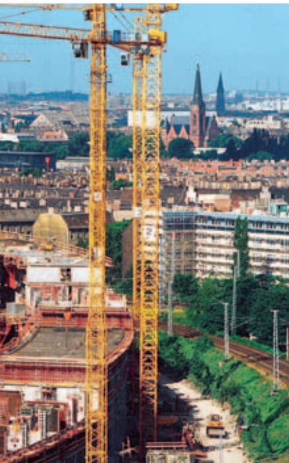
UNIPORTAL -pöytämuotteja rakennustyömaalla.
