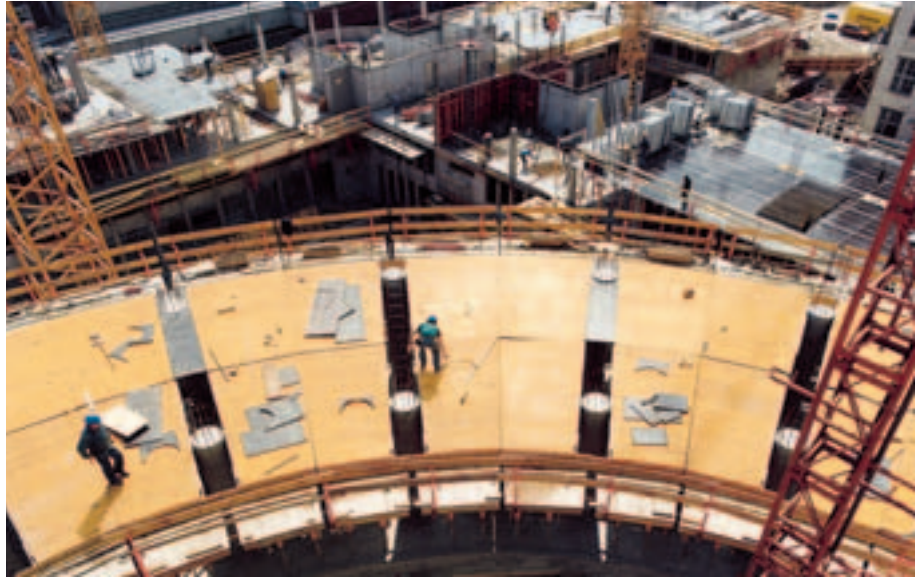
Täyttökaistat on sijoitettu pilarilinjoille.
