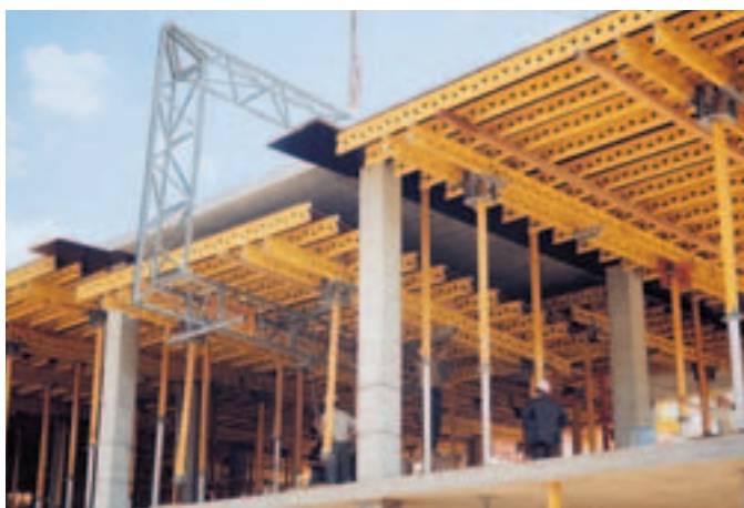
5,40 m leveät ja 7,00 m pitkät UNIPORTAL -pöytämuotit.
